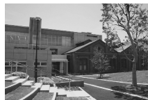
北区立中央図書館 大正8(1919)年に建設された赤レンガ倉庫(旧陸上自衛隊十条駐屯地275号棟)と新築部分を一体化した、愛称「赤レンガ図書館」。平成21年度グッドデザイン賞を受賞。
