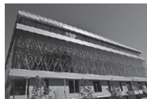
新しくオープンした「晴海区民センター」東京2020大会レガシーとして、ビレッジプラザで活用した木材を一部使用しています。
