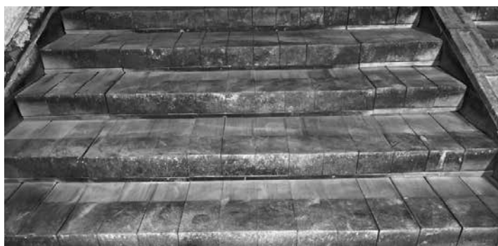
焼却炉内の火格子
