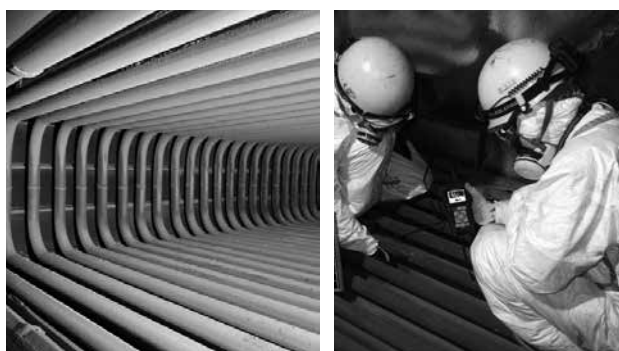
ボイラ水管と肉厚測定中の様子
