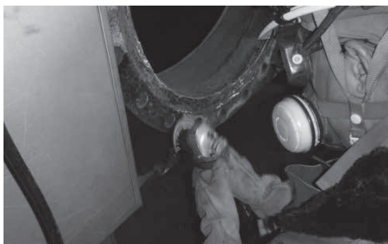
設備を補修している様子
