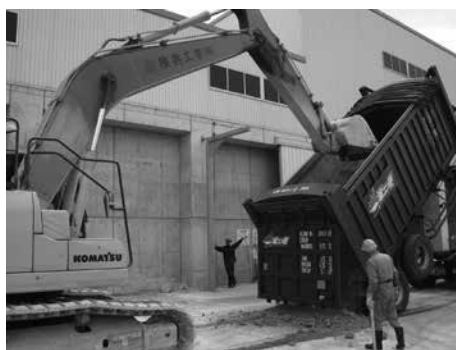
図10 重機による掻き出し状況
