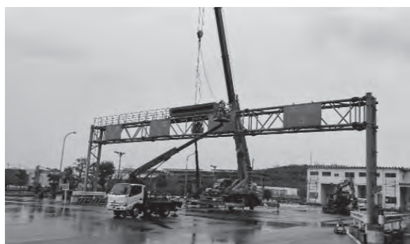
大型標識の撤去作業
