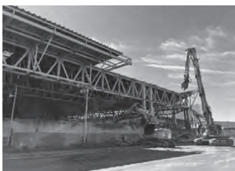
受入貯留ヤード棟屋根の解体状況
