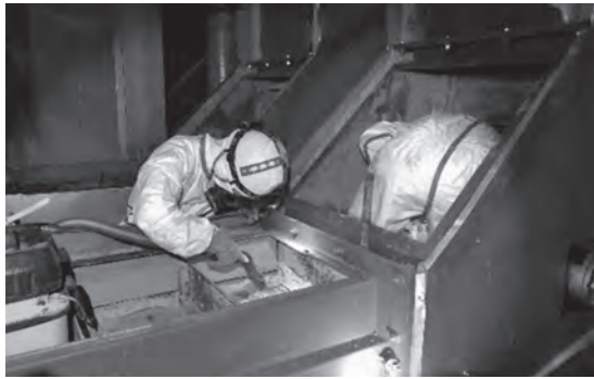
飛灰搬出設備の洗浄状況
