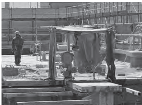
ワイヤーソー工法
