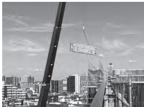
工場棟外壁パネルの撤去状況
