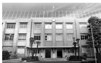
国立印刷局東京工場
