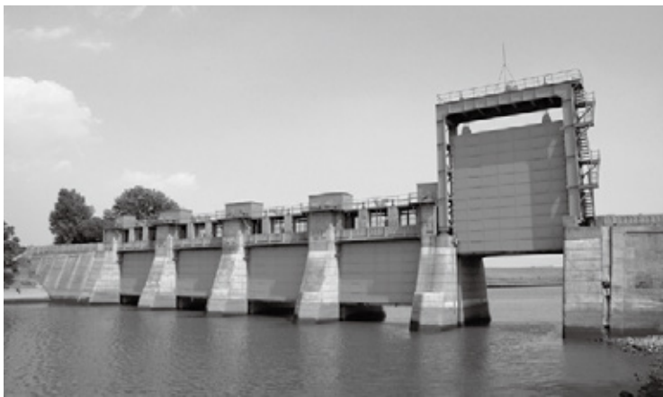
【旧岩淵水門】も治水の近代産業遺産として認定。赤水門とも呼ばれている
