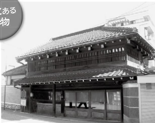
今でいう再生紙を扱う旧地漉紙問屋「松屋」横山家の家屋。江戸時代の伝統的な商家建築で、荷物を運び込む1階の空間を大きくとるために2階の床と兼用する踏み天井や、軒を深くとる出桁（だしげた）造りなどが特徴的
