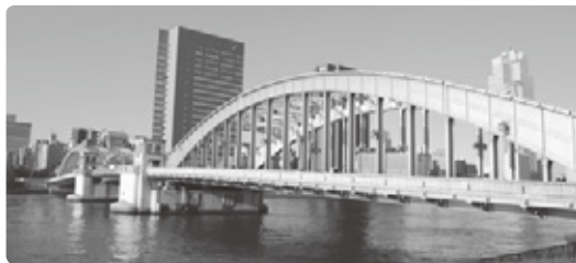
昭和45年11月29日の開閉を最後に、中央部の開閉が行われなくなった勝鬨橋
