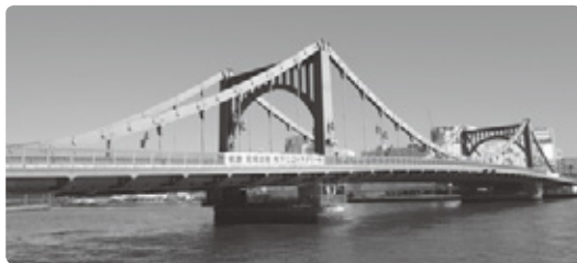
ドイツのライン川に架かるケルンの吊り橋をモデルに設計された清洲橋。懸垂線を描く橋は女性的な橋となっている
