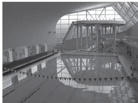
温水プール(千歳清掃工場から熱供給)
