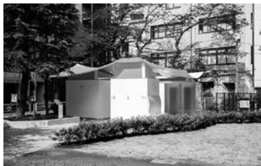
恵比寿東公園トイレ 恵比寿1- 2-16 横文彦 (建築家) タコ公園のイカトイレ。単なるパブリックトイレとしてだけでなく、休憩所を備えた公園内のパビリオンとして機能する公共空間として考えた爽やかで、少しユーモアのあるデザインです。
