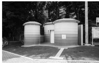
代々木八幡公衆トイレ 代々木5- 1- 2 伊東豊雄（建築家） Three Mushrooms。代々木八幡宮の森から生まれた3本のキノコのようなトイレ。個室型のトイレを3つに分散させることで回遊性を生み出し、行き止まりがなく視線が抜けることで防犯性を高めています。
