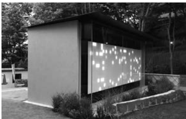
広尾東公園トイレ 広尾4- 2-27 後智仁（クリエイティブディレクター・アートディレクター） Monumentum。多くの緑に囲まれた公園内にあるパブリックアートのようなトイレ。世界人口と同じ79億通りのライティングパターンが、昼は木漏れ日のように、夜は月明かりや漂う蛍のように変化し続けます。
