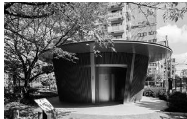
神宮通公園トイレ 神宮前6-22- 8 安藤忠雄（建築家） あまやどり。公共トイレという機能だけではない、都市施設としての意味、パブリックな価値を持つものでありたいとの考えから、円形平面の棟から屋根根庇が大きくせりだし造形になりました。
