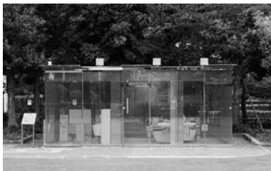
はるのおがわコミュニティパークトイレ 代々木5-68- 1 坂 茂 (建築家) ザ トウメイ トウキョウ トイレット。新しい技術で作られた鍵を締めると不透明になるガラスで外壁を作ることで、トイレに入る前に中の様子を確認できます。夜には美しい行燈のように公園を照らします。
