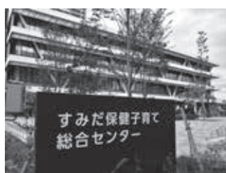
すみだ保健子育て総合センターの外観
