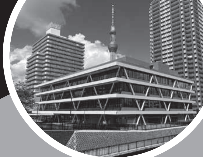
すみだ保健子育て総合センター施設外観
