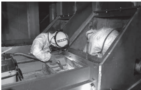
飛灰搬出設備の洗浄状況
