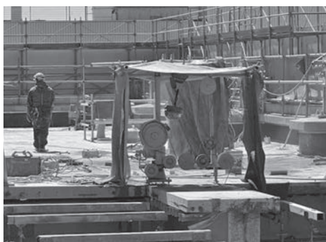
ワイヤーソー工法
