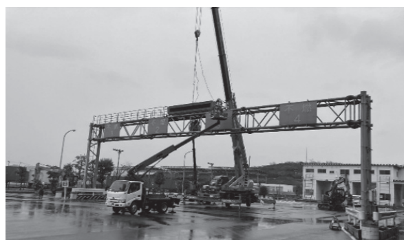
大型標識の撤去作業
