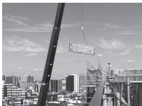
工場棟外壁パネルの撤去状況
