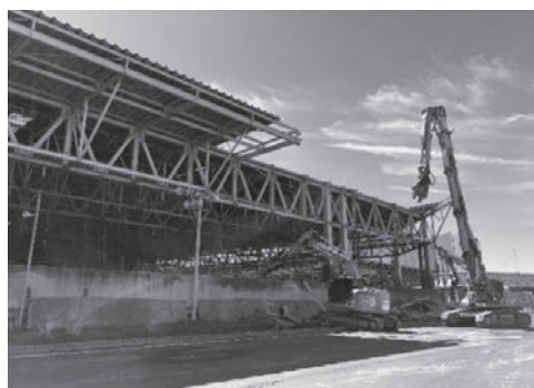
受入貯留ヤード棟屋根の解体状況
