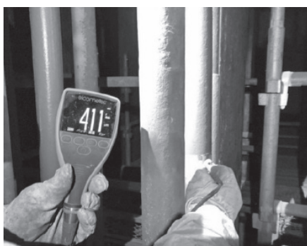
ボイラ水管の膜厚測定
