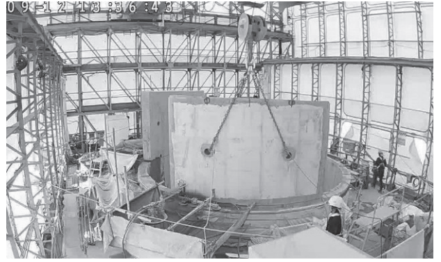
ハットダウン工法による煙突解体
