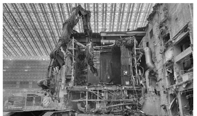
解体工事状況（令和4年5月）
