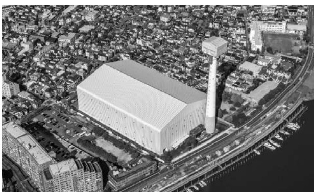
解体中の航空写真（令和4年8月）
