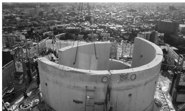
煙突外筒解体状況
