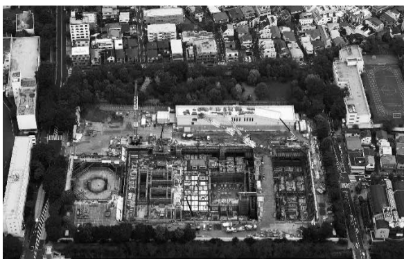
【新】目黒清掃工場建設状況（令和2年9月撮影）
