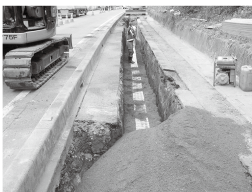
図3 施工現場（下層路盤材に使用）
