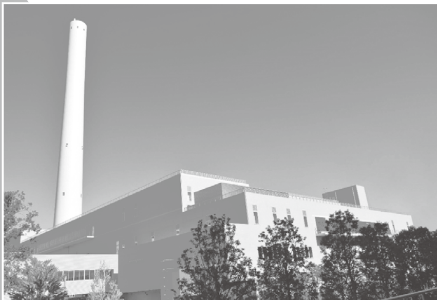
▲ 23区最新の「光が丘清掃工場」(令和3年3月しゅん工)
