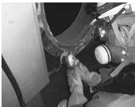
設備を補修している様子
