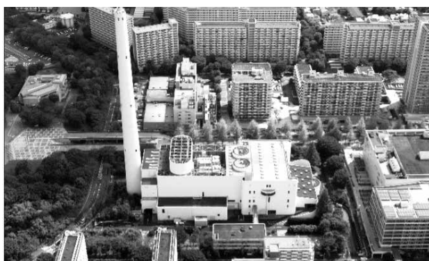
【旧】光が丘清掃工場（平成28年5月撮影）
