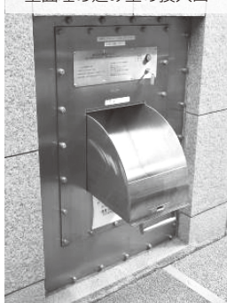
壁面埋め込み型の投入口
