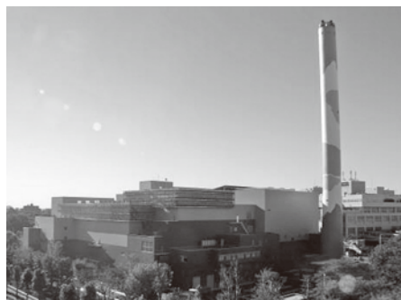
↑ 世田谷清掃工場の煙突
