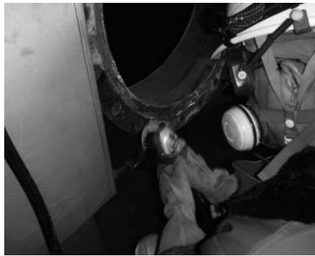
設備を補修している様子
