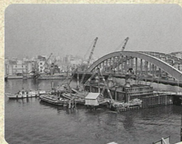
江東区：地下鉄東西線の建設 (永代橋そば・1965年)
