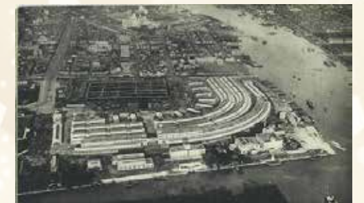
竣工当時の築地中央卸売市場
