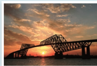
東京ゲートブリッジ
