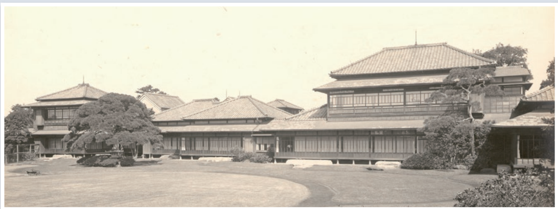
1908年(明治41年) 三田綱町に移築、増改築 (清水建設株式会社所蔵)
