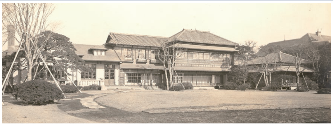
1929年(昭和4年) 洋館増改築 (清水建設株式会社所蔵)
