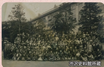
滝野川町役場新築地鎮祭 (大正7年12月1日)
