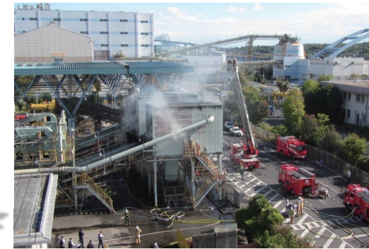
粗大ごみ破砕処理施設の火災の様子
