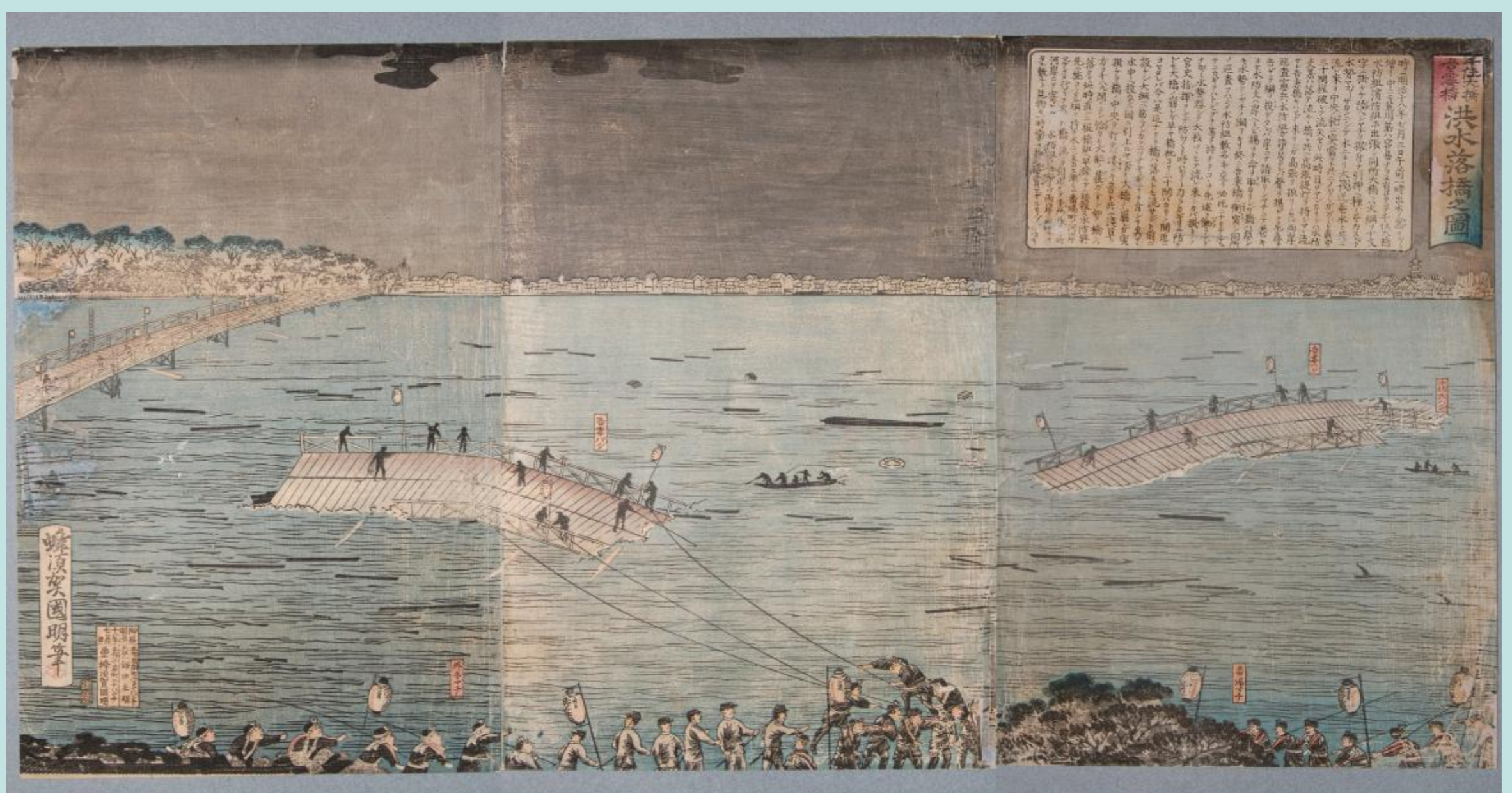
▲ 二代歌川国明「千住大橋吾妻橋洪水落橋之図」明治18（1885）年 明治18年7月3日、大洪水で千住大橋が落橋しました。流れた千住大橋は吾妻橋に衝突し、二つの橋が流出しました。二代国明は、その時の様子を克明に描いています。
