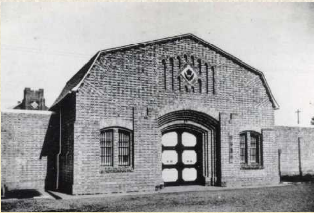
竣工当時の表門
