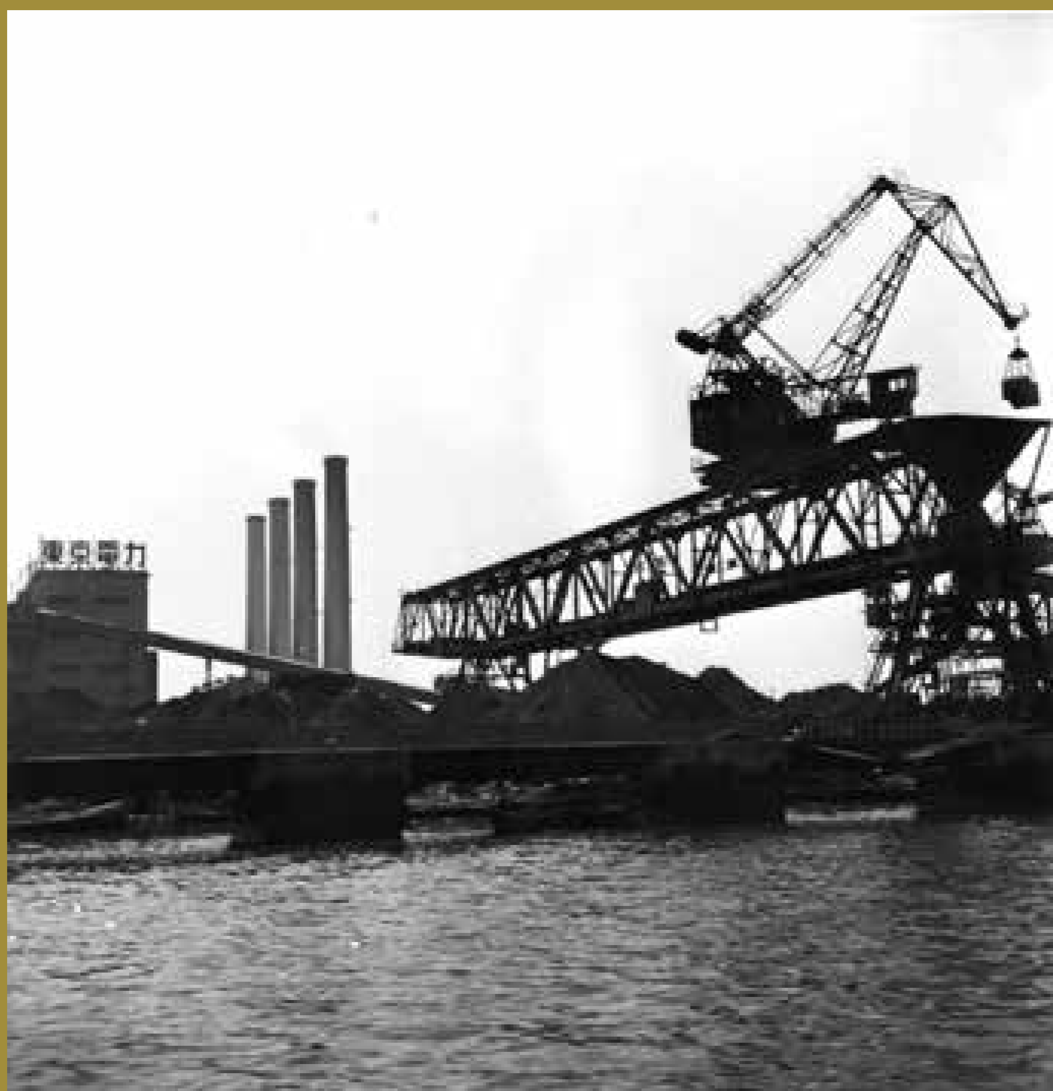
豊洲 6-1・2 付近 新東京火力発電所（江東区教育委員会 所蔵）
