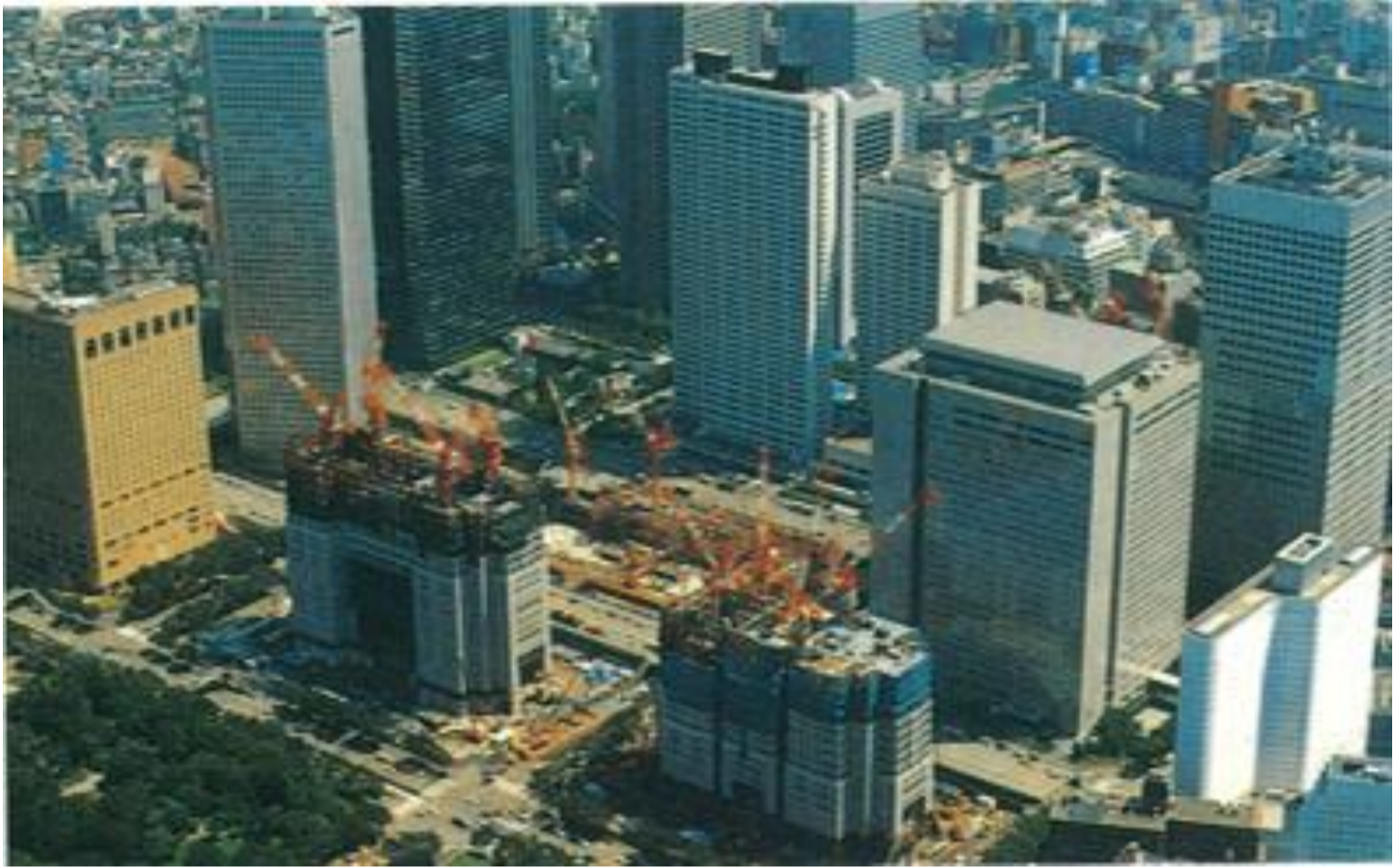
工事風景 『新都庁建設誌』(請求番号:財務 F91)
