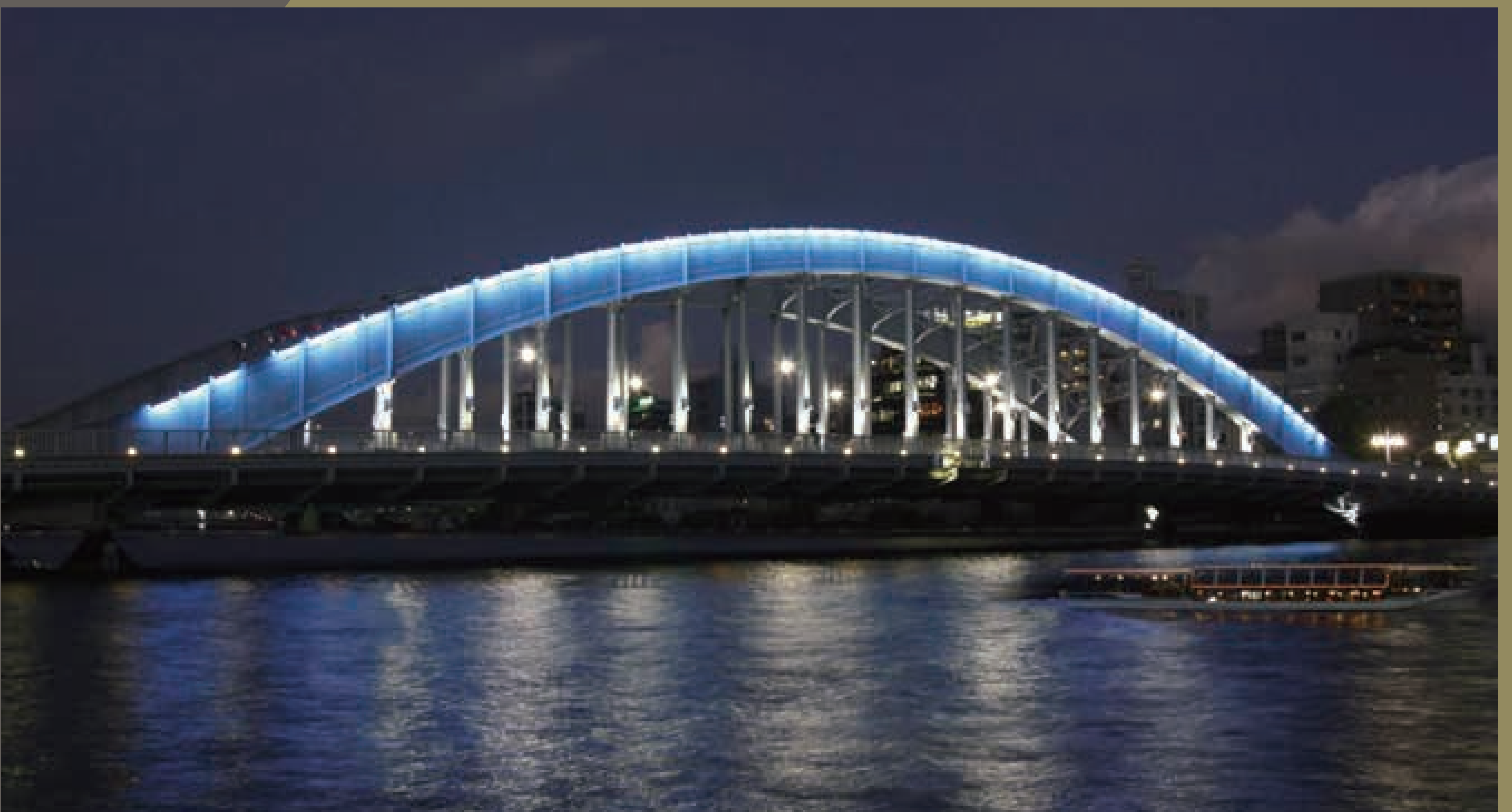
現在の永代橋
