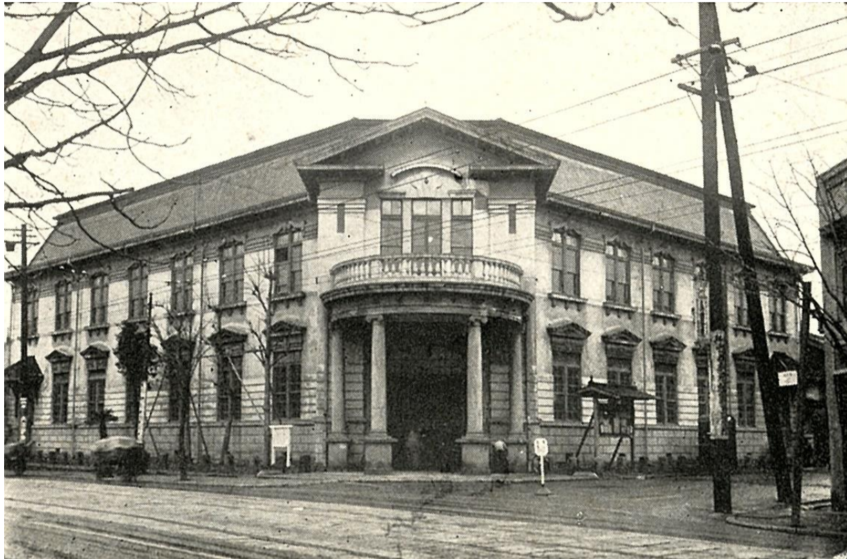
「麻布区役所庁舎」東京市麻布区役所『東京市麻布区勢一斑』昭和8年(1933)
