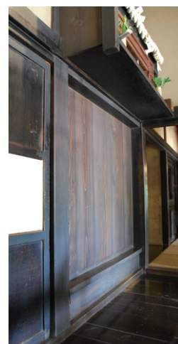
世田谷区旧安藤家住宅主屋にある押板
