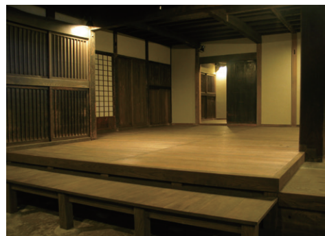
6 完成した土壁
