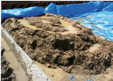
1 荒木田土に藁スサを混ぜた壁土
