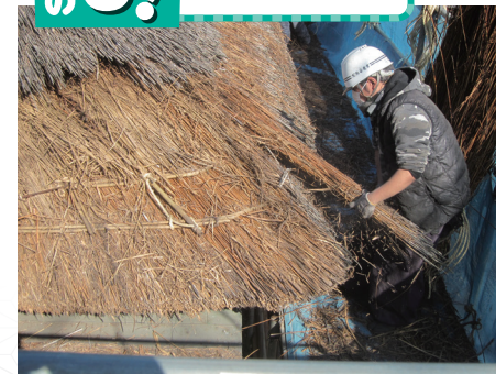
平成29年の葺替え工事の様子
