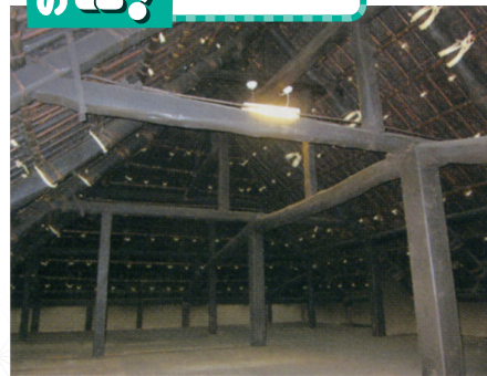
屋根裏の様子 ※屋根裏の見学はできません
