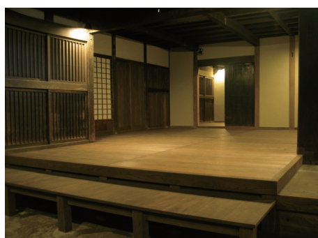
6 完成した土壁
