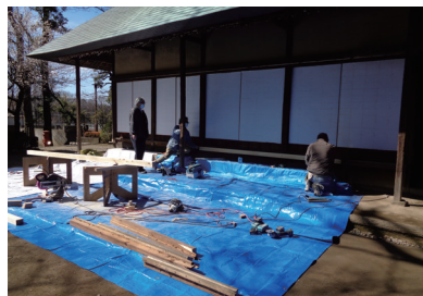
雨戸の敷居の取替工事
