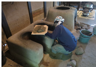
カマドの補修
