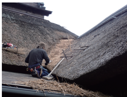
北側屋根の角屋と接する部分の 差茅工事 令和4（2022）年3月
