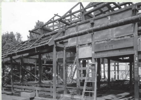
ヤナカ竹・木舞の撤去、解体の様子 (昭和54年8月4日撮影)
