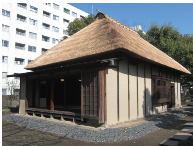
葺替え工事後の茅葺き屋根
