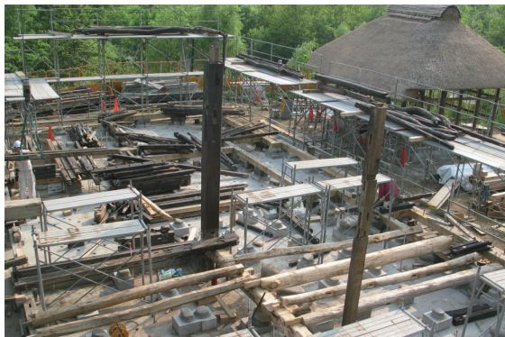
移築復原工事
