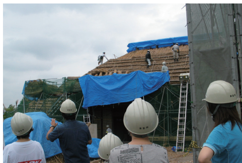
工事現場での解説会
