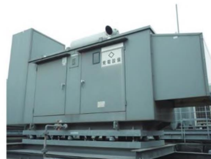
屋上の自家発電設備。停電時、自動稼働する
