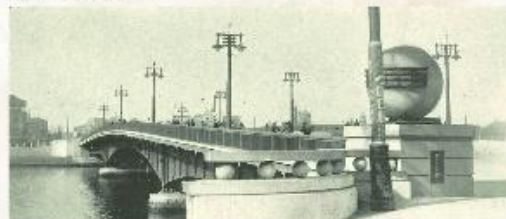
施工：東京市 型式：上路型突桁式鋼板桁 橋長：164.500m 橋幅：24.000m 起工：昭和5年2月19日 開通式：昭和7年5月18日
