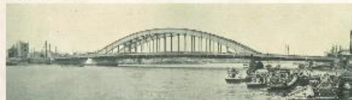
施工：国（復興局） 型式：下路型突桁式鋼板桁（中央）及鋼桁半桁（両側） 橋長：185.186m 橋幅：22.048m 起工：大正13年12月1日 開通式：大正15年12月20日
