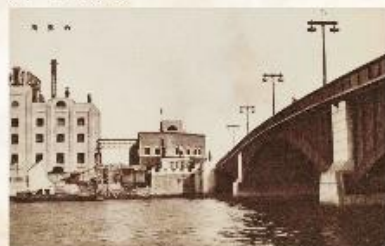
施工：東京市 型式：上路型二鉄桁鋼板拱 橋長：150.000m 橋幅：20.000m 起工：昭和4年6月 竣工式：昭和5年12月20日
