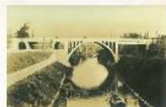
隅田川以外の復興橋梁（聖橋）
