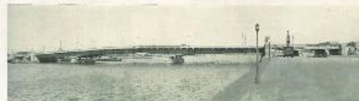
施工：国（復興局） 型式：上路型突桁式鋼板桁及鋼桁連納桁（陸橋部） 橋長：238.364m 橋幅：22.000m 起工：大正14年5月11日 開通式：昭和3年2月10日
