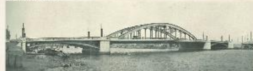
施工：国（復興局） 型式：下路型二鉄桁鋼板桁（中央）及上路型二鉄桁鋼板桁（両側） 橋長：148.793m 橋幅：22.000m 起工：大正13年7月25日 開通式：昭和2年6月25日
