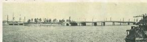
施工：国（復興局） 型式：上路型突桁式鋼板桁、上路型鉄筋単桁 橋長：大橋/145.974m 小橋/45.822m 橋幅：大橋/21.996m 小橋/21.996m 起工：大正13年8月15日 竣工：大正15年11月20日 開通式：大正15年11月22日 現在の橋：平成12年架設
