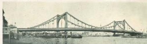
施工：国（復興局） 型式：吊橋 橋長：186.600m 橋幅：22.000m 起工：大正14年3月19日 開通式：昭和3年3月15日
