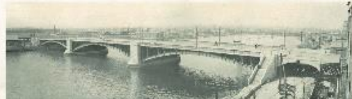
施工：国（復興局） 型式：上路型二鉄桁鋼板桁及二鉄桁鉄筋混泥土拱（片側） 橋長：173.196m 橋幅：22.000m 起工：大正13年9月2日 開通式：昭和2年11月26日
