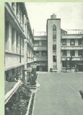
黒門小学校 台東区上野 昭和5年(1930)竣工
