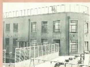
旧京華小学校 (京華スクエア) 中央区八丁堀 昭和4年(1929)竣工
