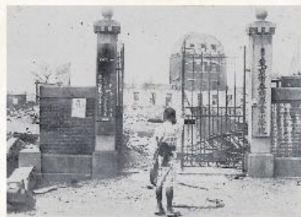
焼失した泰明尋常小学校
