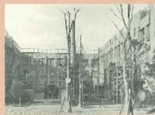
旧元町小学校 (整備中) 文京区本郷 昭和2年(1927)年竣工
