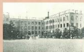
旧箱崎小学校 (水天宫ビット) 中央区日本橋箱崎町 昭和3年(1928)竣工
