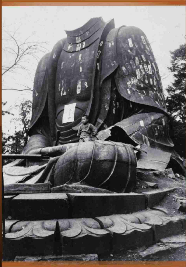
上野公園内大仏の破損（震災被害状況）
